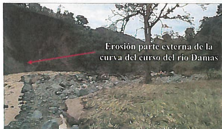
Fotografía 14. Producto del gran caudal en el río Damas trozos de roca fueron arrastrados por la corriente provocando erosión en la parte externa de la curva del curso del río producida por la fuerza centrífuga provocando deslizamientos en tramos de la vía de tercer orden.
