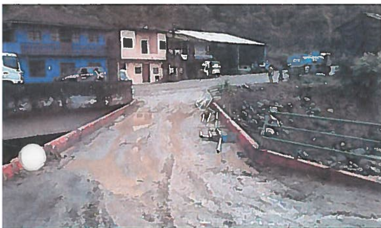
Fotografía 20. Producto de la gran crecida del caudal (agua, lodo y escombros) se puede observar que el estribo derecho del puente se encuentra en mal estado.
