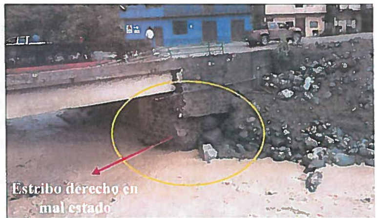
Fotografía 20. Producto de la gran crecida del caudal (agua, lodo y escombros) se puede observar que el estribo derecho del puente se encuentra en mal estado.
