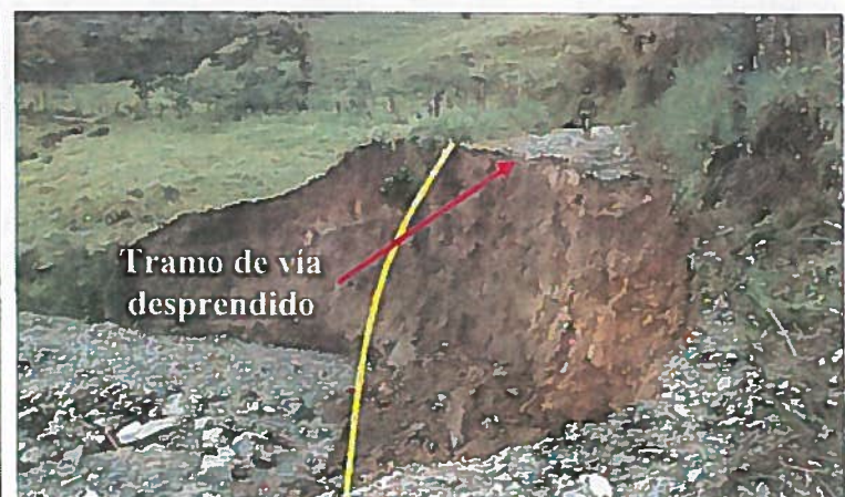
Fotografía 14. Producto del gran caudal en el río Damas trozos de roca fueron arrastrados por la corriente provocando erosión en la parte externa de la curva del curso del río producida por la fuerza centrífuga provocando deslizamientos en tramos de la vía de tercer orden.
