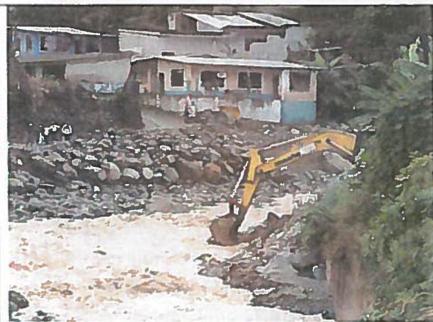
Foto 9. Limpieza del cauce fluvial deformado por el paso del aluvión y desbordamientos del río Alluriquín en el poblado del mismo nombre.
