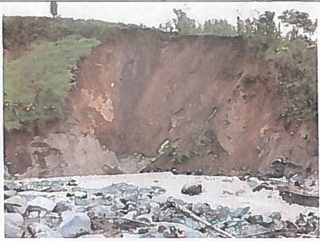
Foto 4. Deslizamiento detectado aguas arriba de la cuenca media, en el río Damas, afluente del río Alluriquín.
