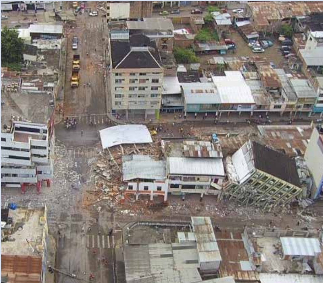
Foto 1. Daños a infraestructura en Portoviejo por terremoto del 16A
