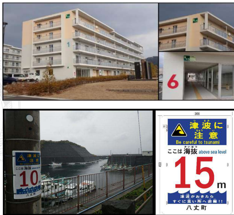
Ilustración 37. Edificio de alojamiento temporal ante tsunamis y señalética (Japón)
