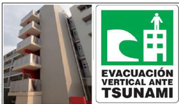
Ilustración 29. Edificios evacuación por tsunami
