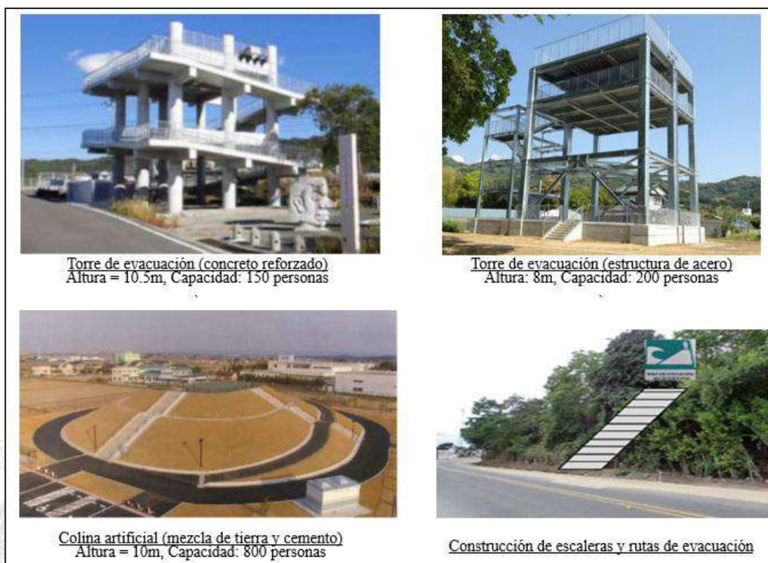
Ilustración 32. Ejemplos de torre de evacuación, escaleras, rutas de evacuación y colina artificial
