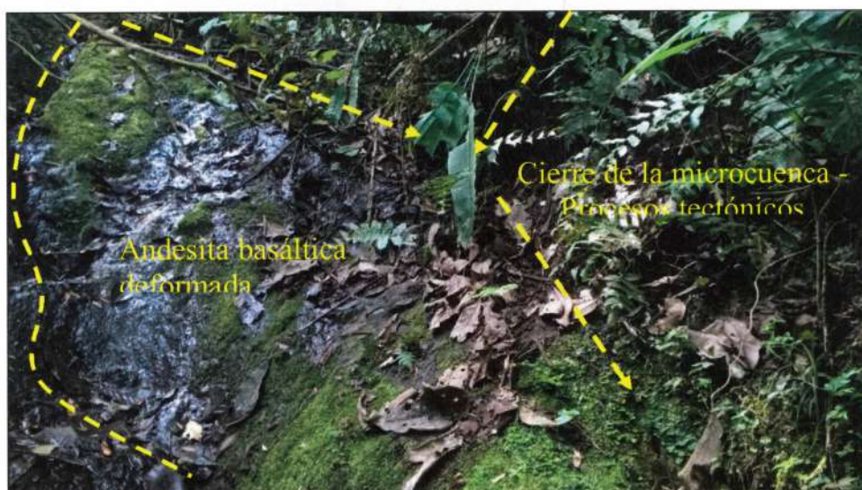
Fotografía 13. . Presencia de acumuladores y flujos de agua, margen derecho del río Toachi
