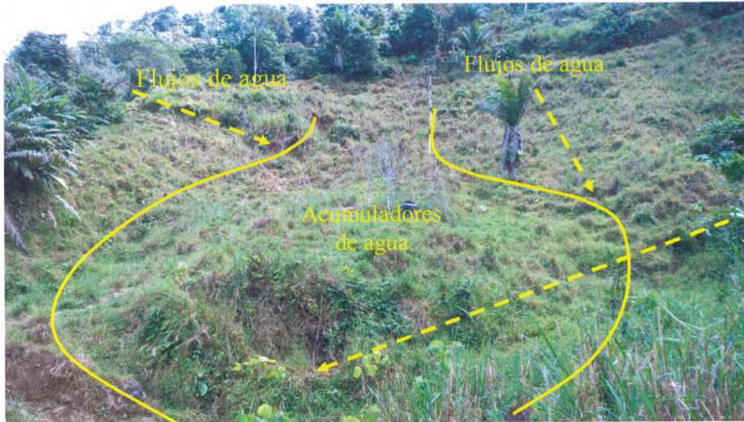
Fotografía 6. Presencia de acumuladores y flujos de agua, margen derecho del río Toachi
