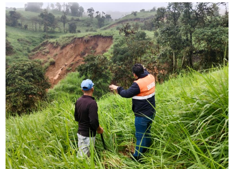
INSPECCIÓN POR MOVIMIENTO DE MASAS – Cantón Chillanes– Provincia de Bolívar
