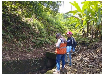
Ilustración 7. Inspección en el GAD Pedro Vicente Maldonado.
