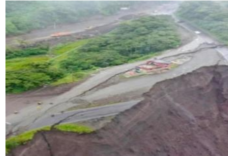
Pérdida de 520 metros de vía en el km 64 - vía E45 y de la vivienda denominada Casa Rosada en San Luis, 18/05/2021
