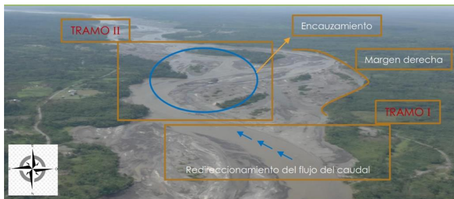
Encauzamiento y redireccionamiento del flujo del caudal, noviembre 2022.
