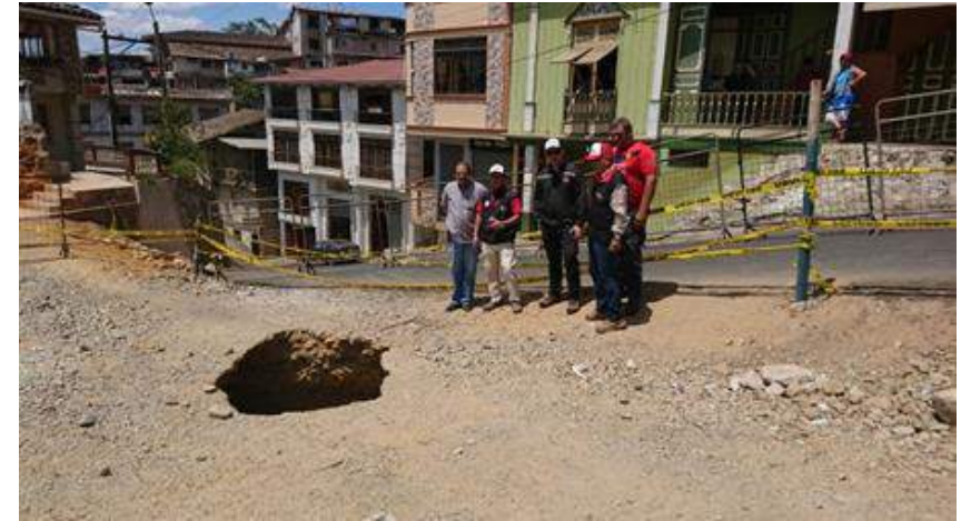
Hundimiento en escuela La Inmaculada, Septiembre 2019
