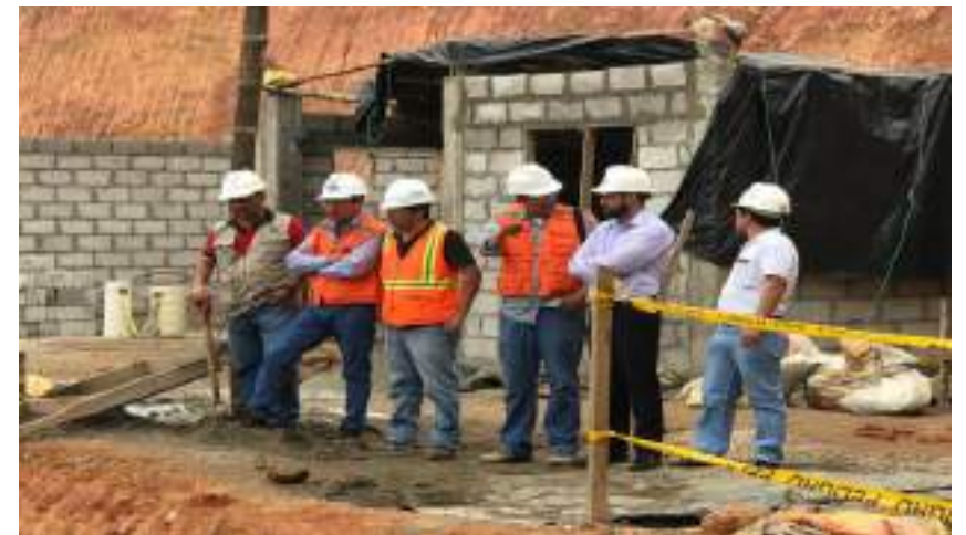
Inspecciones técnicas - infraestructura de Agua y Saneamiento, mayo 2019
