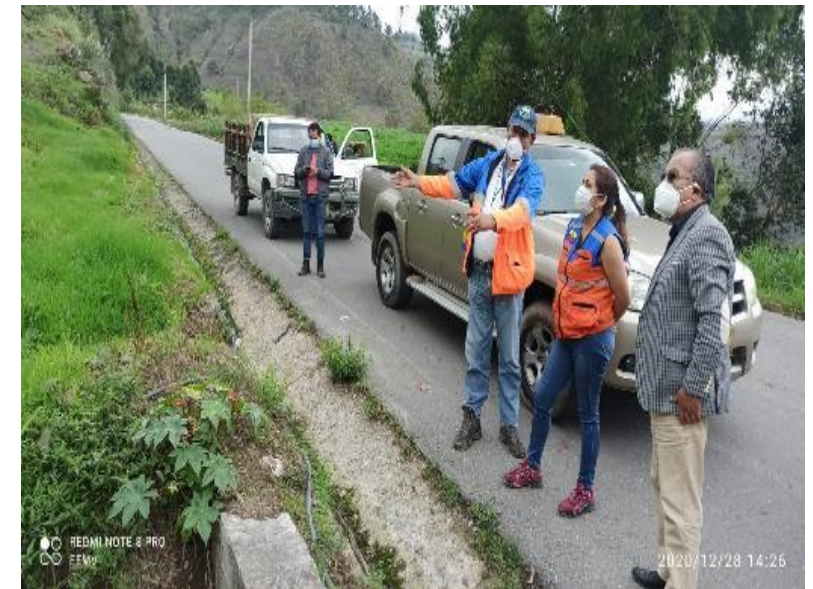
Inspección técnica realizada en el cantón Chunchi, en diciembre, por deslizamiento en el sector de la Armenia y la Cullpa
