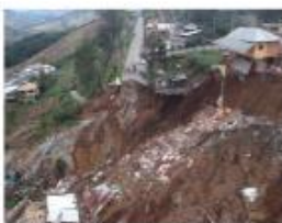
Afectación e la vía Chimbo – El Cristal
