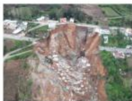
Deslizamiento en el barrio Tambán
