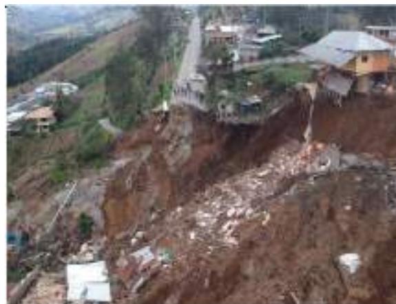
Afectación e la vía Chimbo – El Cristal
